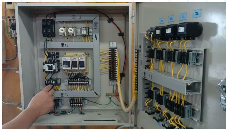
基礎配管、配線技術
